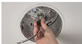
Step 2: Install E26 socket adapter
